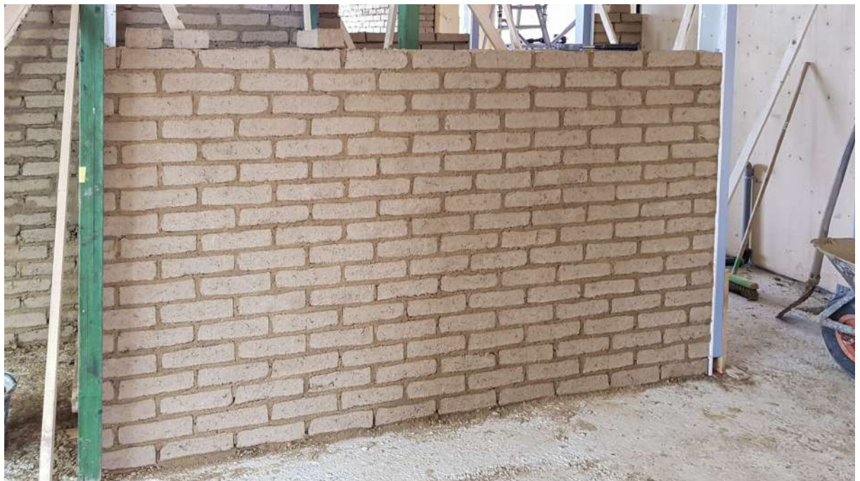
Figuur 3.1.4.2 - 1 | leemsteen metselwerk
