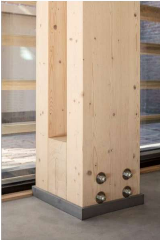
4.2.6.1. Figuur 14 | gelamineerde houten kolom: https://platformcb23.nl/wp-content/uploads/PlatformCB23_Leidraad_Losmaakbaar-detailleren.pdf - pg 41
